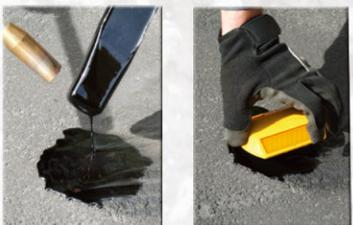
**科来福胶棒** 能够方便快捷的粘帖路标和修补小的道路裂缝。使用时您只需要用一个小的热喷枪加热材料，温度达到要求后即可使用。胶棒适合粘帖路面标志和修补小的裂缝，在沥青和水泥路面上使用都可以取得很好的效果。
